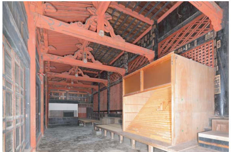
写真2 本堂外陣全景（修理前）
