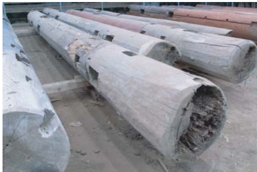
写真3 蟻害による柱の破損
