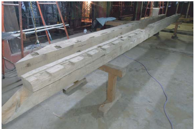
写真10 床下の転用材（手前から頭貫、隅木）
