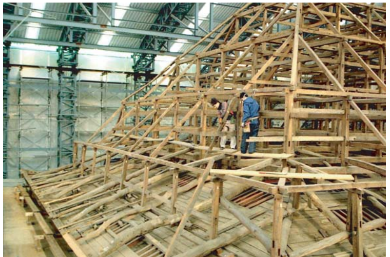
写真5 小屋組解体中
