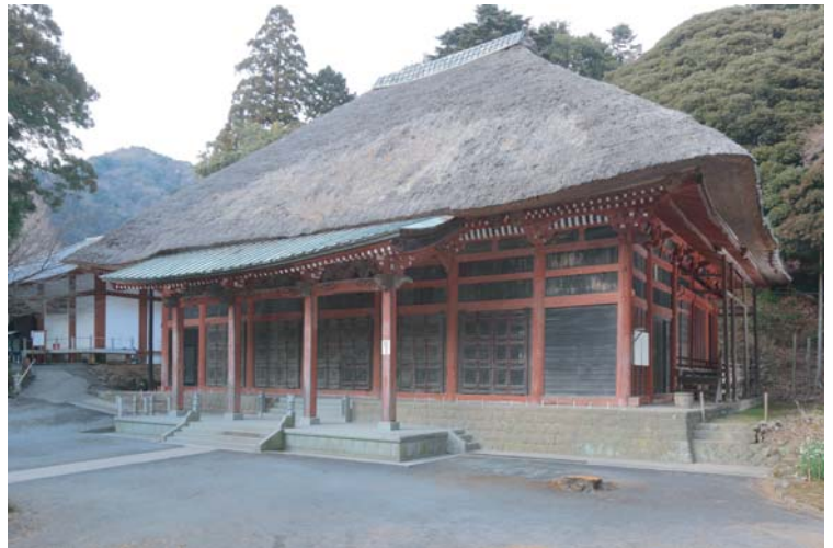
写真1 本堂正面全景（修理前）
