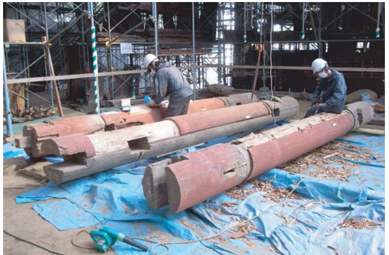
写真6 柱補修中
