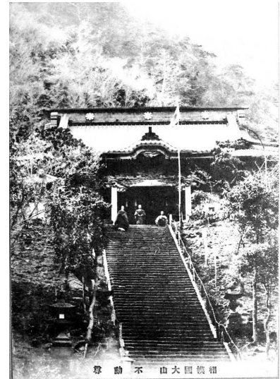
写真 28 再建された大山寺本堂
