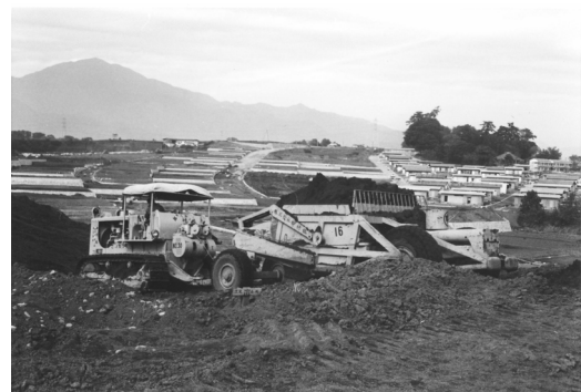
写真30 八幡台の造成(昭和30年代)
