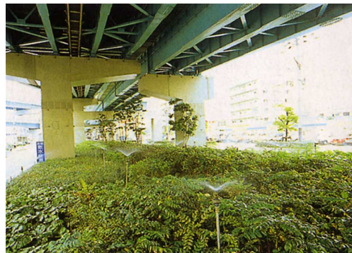
高架下の緑の連続性確保（首都高，幡ヶ谷）
