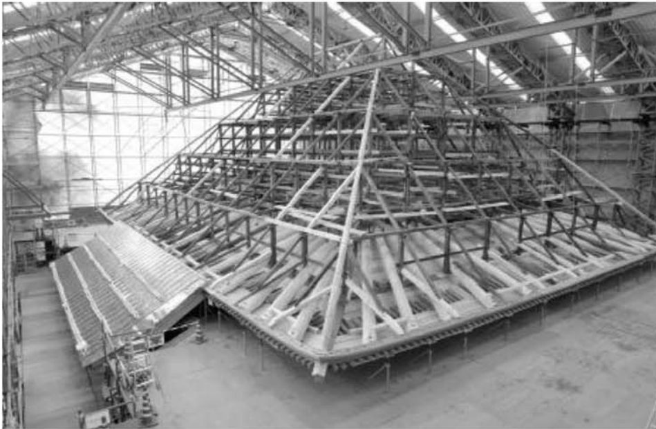
小屋組が組み上がった日向薬師宝城坊本堂
