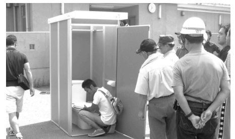
マンホールトイレ設営
