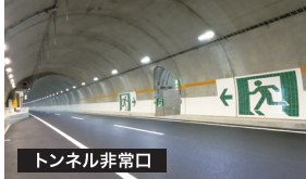
トンネル非常口
