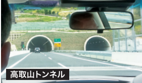
高取山トンネル
