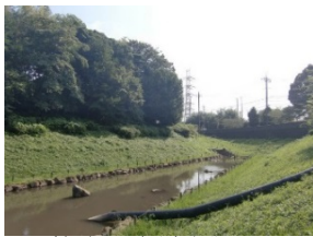
調整池下流(南側)
