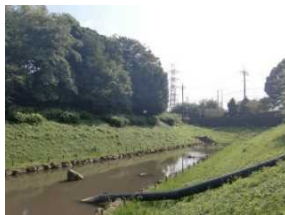
調整池下流(南側)
