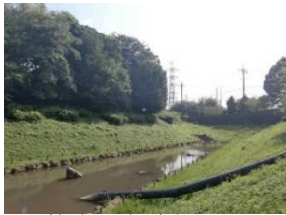
調整池下流(南側)
