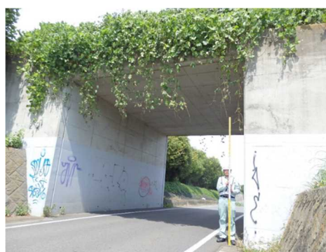
立体交差 (市道 85 号線)
