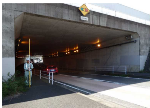
立体交差 (市道 740 号線)
