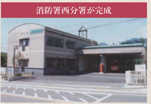
市西部地域の消防・防災活動を充実するため、三ノ宮に市内3番目の消防署が完成
