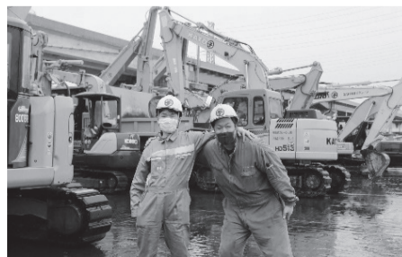
大型重機約200台が稼働しています
