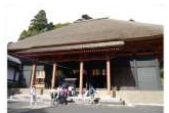
▲修理後の本堂
