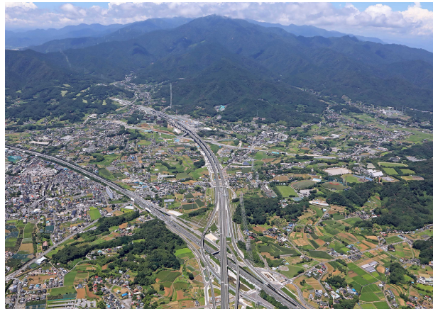
NEXECO 中日本提供 2022年7月30日撮影
