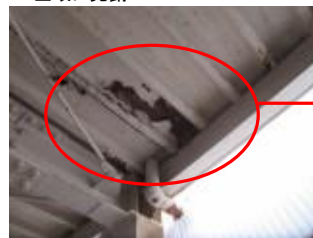
地下1階、1階天井鋼板の劣化・断面欠損(計39箇所)
