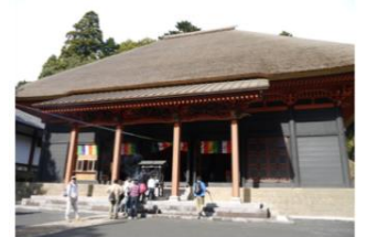
▲修理後の本堂
